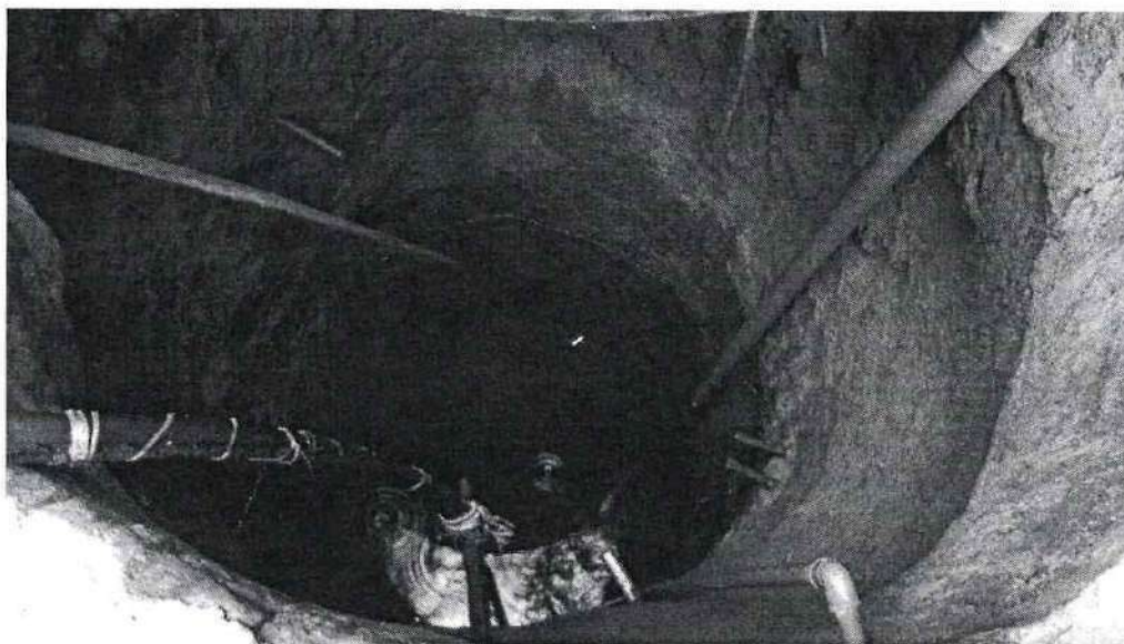
Poço da escola, em boas condições.
