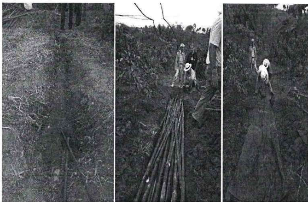
Vala de Bambu em construção em comunidade rural.
